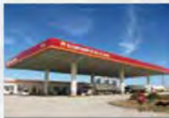
LNG加气站 LNG Fueling Station
