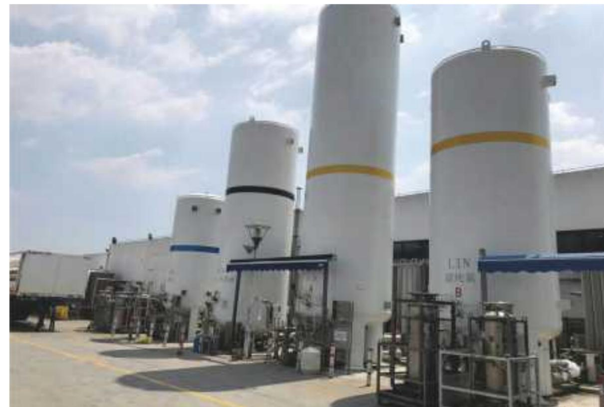
查特成功研发并广泛使用虹吸罐系统，提供经济、可靠和高性能“储罐一泵”系统，广泛用于高压气瓶的充装。虹吸罐系统克服了以往传统的深冷液体贮槽和泵系统效率低下，故障率高等缺点。可大大提高系统的工作效率。查特虹吸罐系统综合了多项创新性深冷技术，此项专利技术有效解决了系统介质损耗、气堵及气蚀问题，可以让低温泵随时快速启动。
