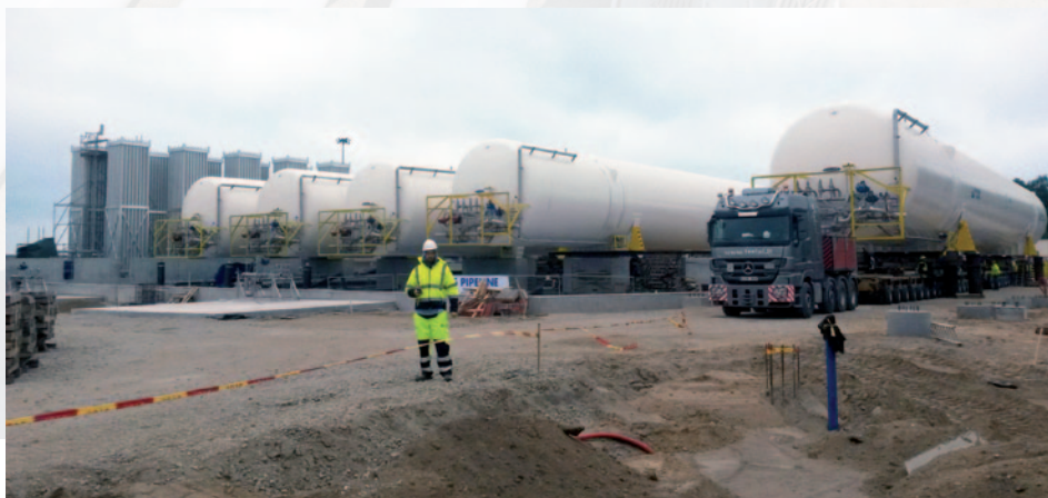
Poslední HT 1000 přijíždí na stavbu
