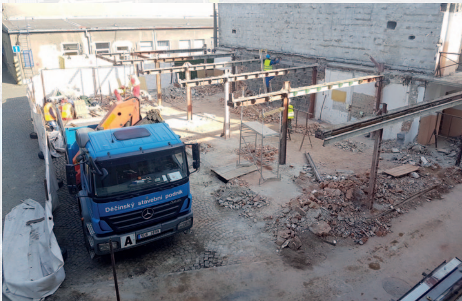
Demolice objektu číslo 10
