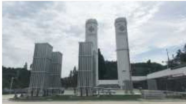
安吉丰陵多功能LNG储备站
