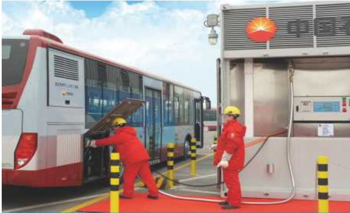
中国首座箱式LNG撬装加气站—中石油北京潞城站
