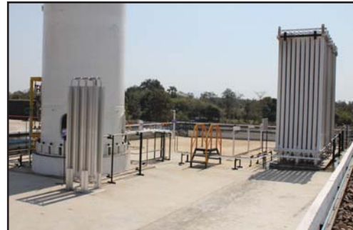
LNG Storage Tank & Vaporizers
